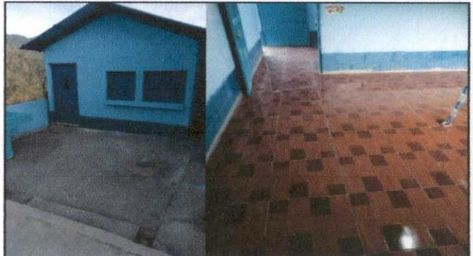
Foto 2: Sustitución de piso de cemento líquido Y Sustitución de piso de ceramico
